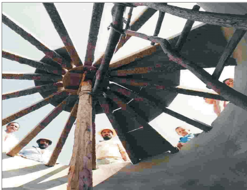
Foto 6 – Detalhes da Estrutura da Tampa da Cisterna
