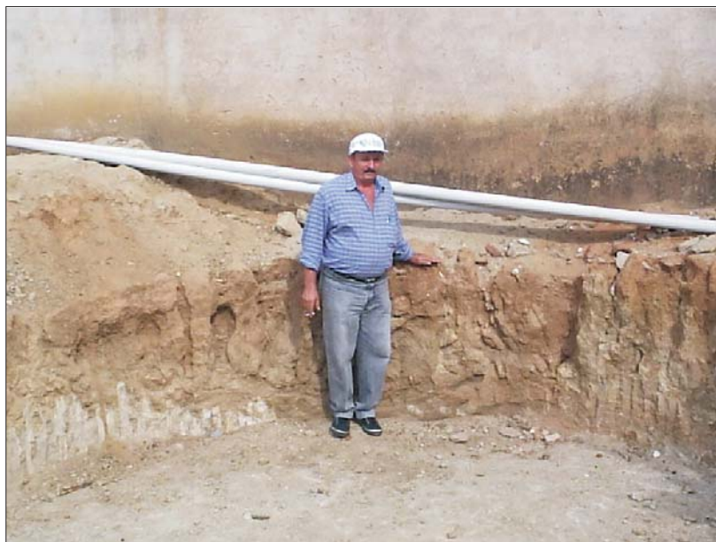
Foto 1 – Escavação do Alicerce
