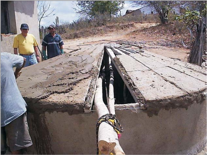
Foto 7 – Detalhes da Montagem da Tampa da Cisterna
