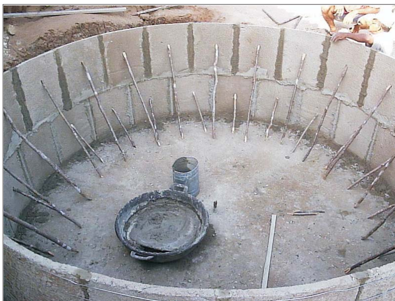
Foto 5 – Detalhes da Montagem da 2ª. Fileira
