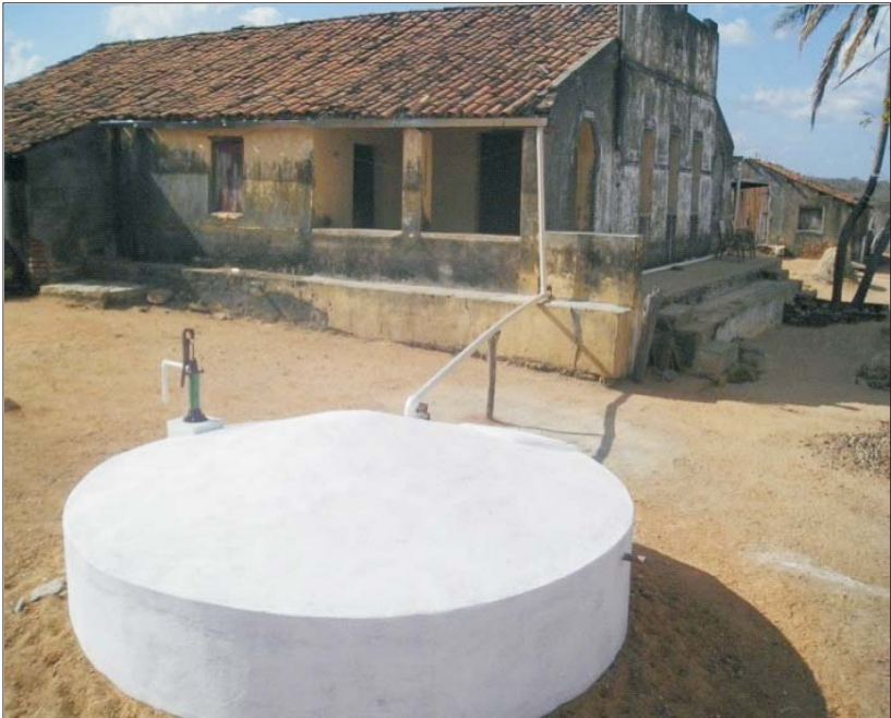
Foto 9 – Cisterna de Placas com Sistema de Captação e Retirada D'água
