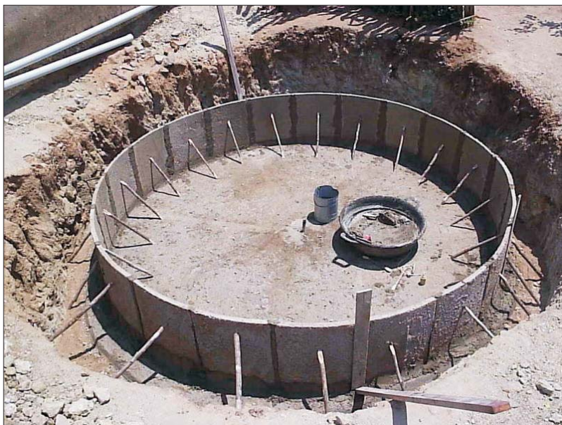
Foto 4 – Montagem da 1ª. Fileira de Placas
