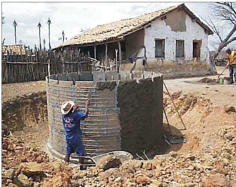
Foto 8 – Aspectos do Reboco Externo da Cisterna
